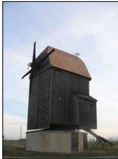
Noch in diesem Jahr soll die Bockwindmühle ihre Flügel erhalten.
