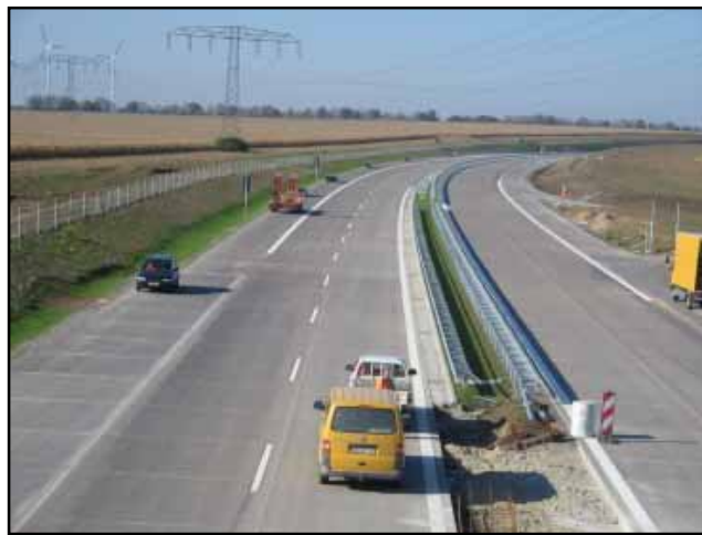
Das letzte große Teilstück der A 38 steht kurz vor der Fertigstellung. Foto: Seidowski
